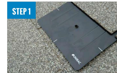
INSTALL FLASHKIT PRO FLASHING
